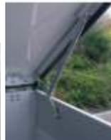
**Deckelschere mit Gasfeder.**
